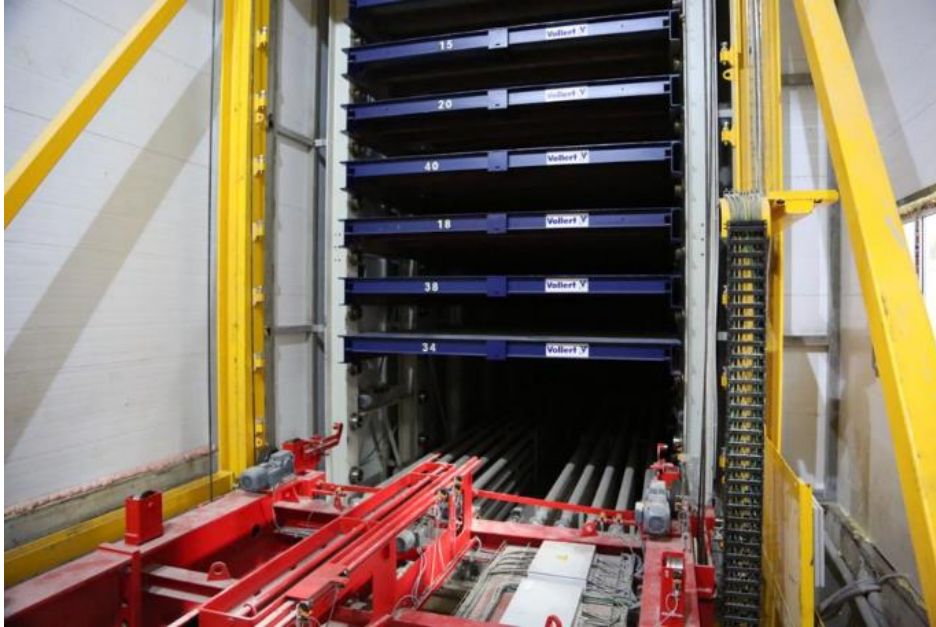
图 7 通过特殊的连接系统，循环托盘成对运输经过货架塔。
