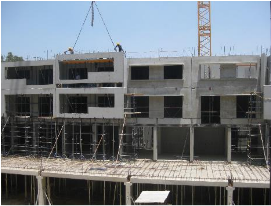
Fig. 3: 政府的“到2022前·让所有人都有房住”项目要求在短时间内建造保障性住房
